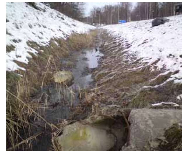
Dagvattendike. Bild: Roslagsvatten AB
